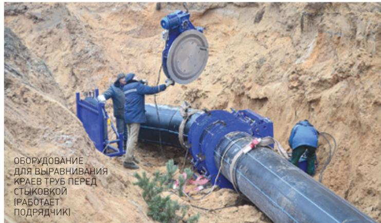
ОБОРУДОВАНИЕ ДЛЯ ВЫРАВНИВАНИЯ КРАЕВ ТРУБ ПЕРЕД СТЫКОВКОЙ (РАБОТАЕТ ПОДРЯДЧИК)
