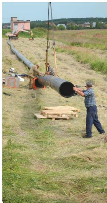
Труба из полиэтилена низкого давления (ПНД) диаметром 500 мм прослужит не менее 50 лет. Материал не образует вну-
